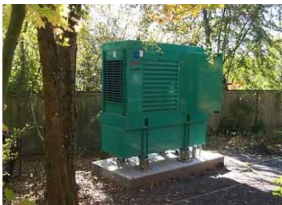
Figura 18. Gjeneratorët janë me kapak për të reduktuar emetimin e zhurmave
