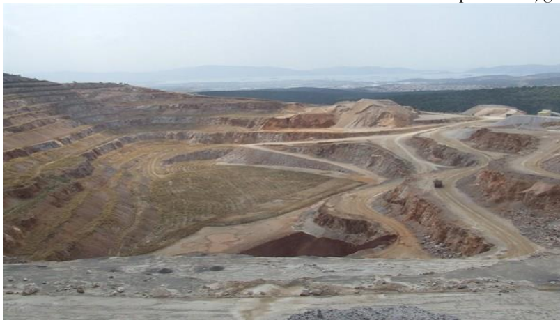
Figura 26. Gurore në fazë rehabilitimi; ana e majtë, ka filluar rritja e vegjetacionit
