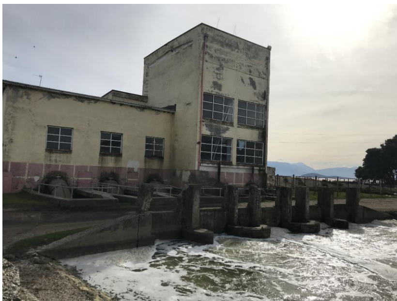
Figura IV-18: Portat dalëse të hidrovorit të Akërnisë
