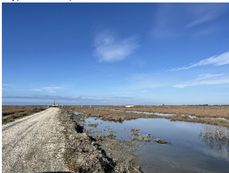
Figura IV-69: Infrastruktura rrugore për në Lagunën e Kellengës (drejtim perëndimor; foto nga eksperti)
