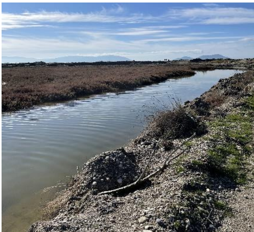
Figura IV-16: Kanal kullues në zonën në studim Kellënge-Godull
