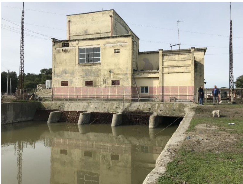
Figura IV-17: Portat hyrëse të hidrovorit të Akërnisë
