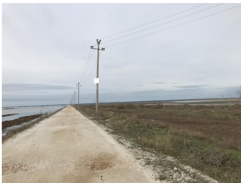
Figura IV-72: Infrastruktura e shpërndarjes së energjisë elektrike në Lagunën e Nartës (foto nga eksperti)
